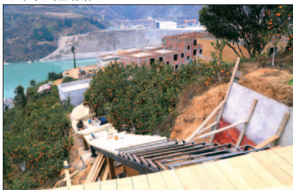
建设中的挖角新村步游道
