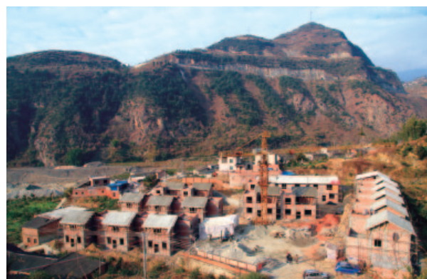
建设中的宰羊乡坪阳新村
